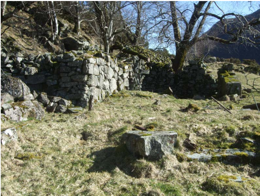
Fjøs /låve bygningen har vært en trebygning med oppmurte vegger mot nord, øst og mot sør i den østre enden. Den har hatt møne retning øst-vest, og med gjødsellageret i den østre enden. Bygningen har hatt plass til en ku og kalv, noen sauer og høns, og kanskje en gris.
